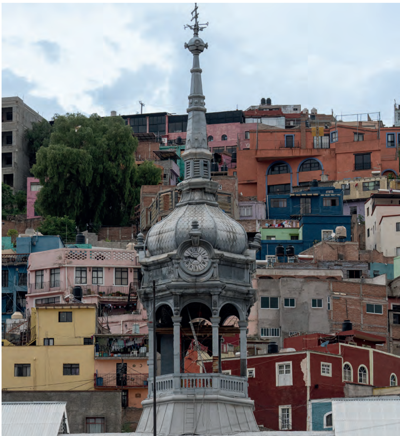
Fig. 53 Estructura del reloj del Mercado Hidalgo
