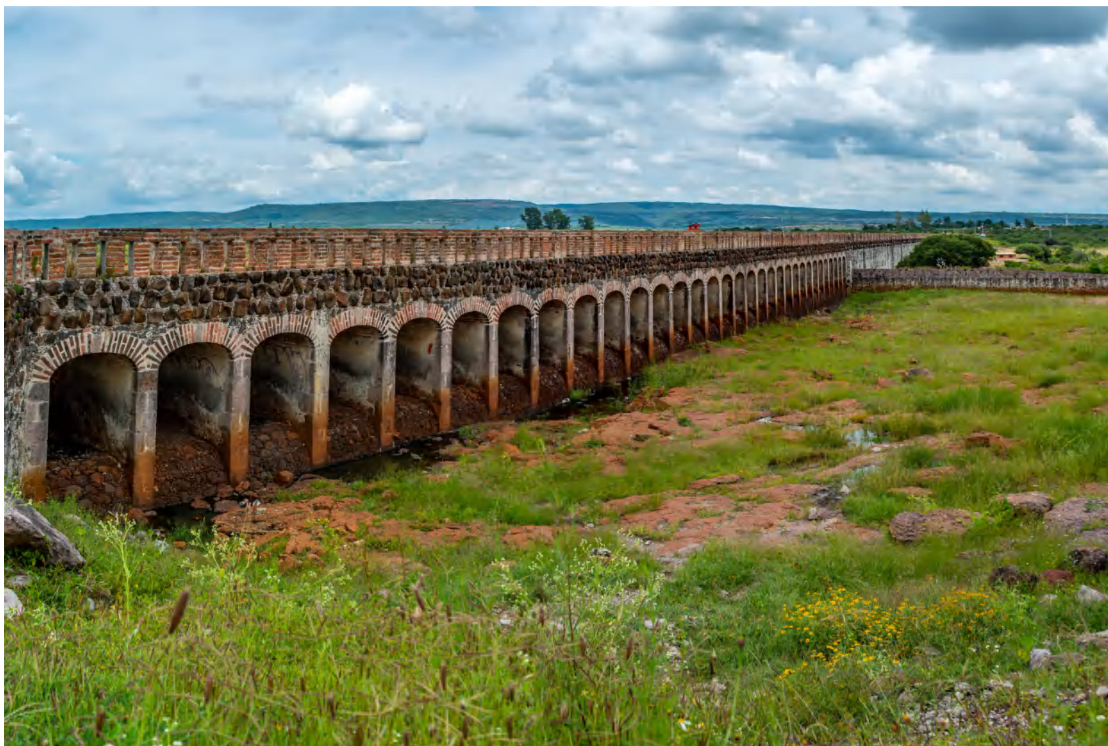
La presa Nueva o de Santa Efigenia, obra de Luis Long. Foto: Gerardo Mendoza Martínez.
