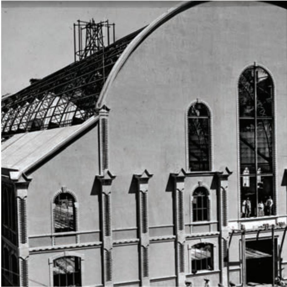
*Fachada lateral del Mercado Hidalgo de Guanajuato, donde se aprecia el proceso de construcción de su cubierta.*
