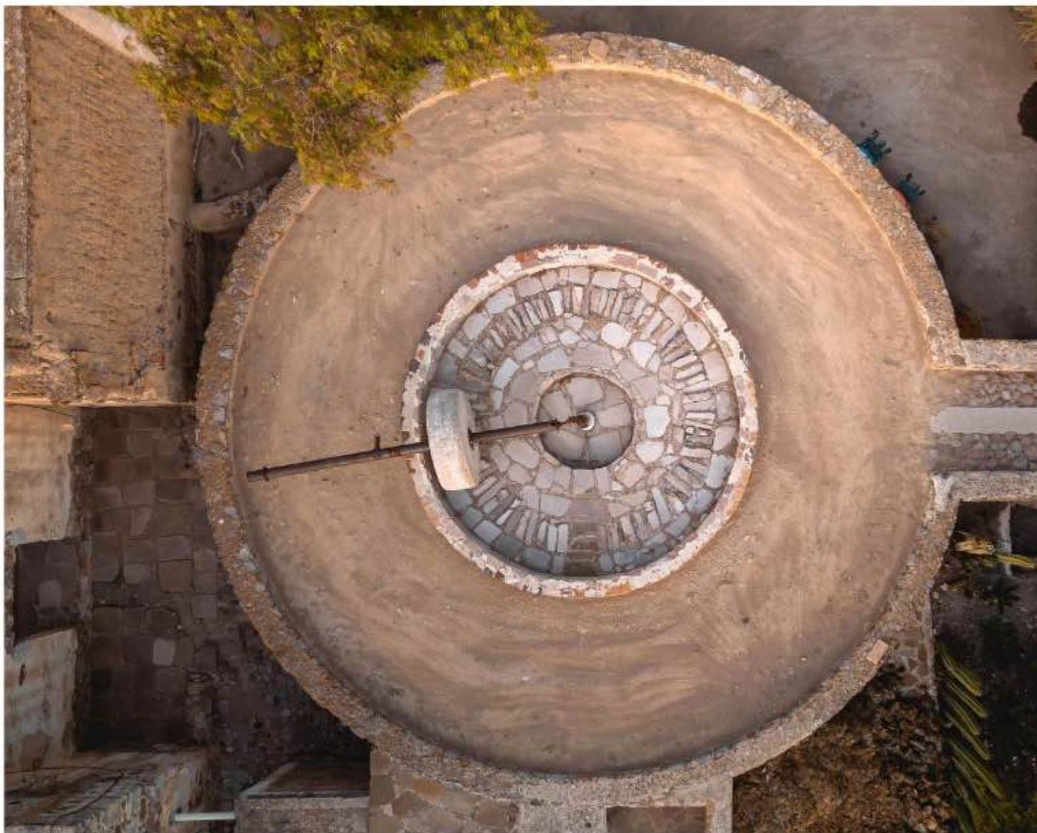
El molino de tahona supuso, en su tiempo, una revolución en la molienda.
